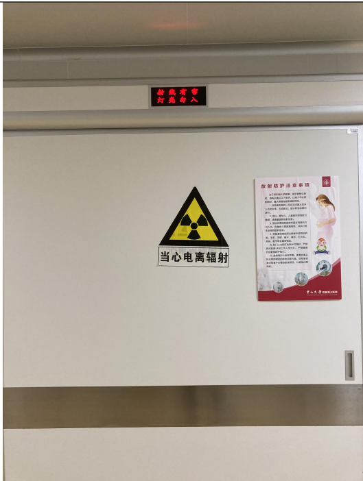
机房大门（关门状态）
