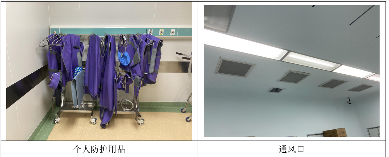
图 3-2 DSA 机房现场照片
